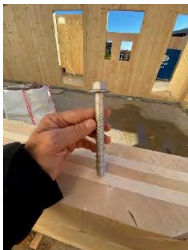
FIGURA 25. Ancoratge SKR per a formigó. FONT: Estudi M103, SLP.
